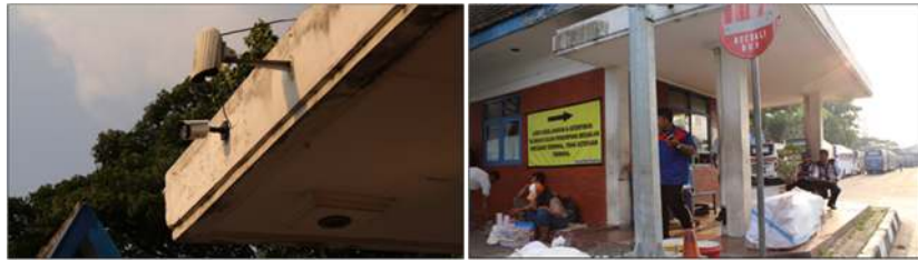
Gambar 6 Fasilitas Keamanan di Kawasan Terminal Leuwipanjang Kota Bandung Sumber: Hasil dokumentasi peneliti, 2017
