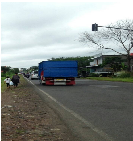
Gambar 8 Kondisi Jalan Tanpa Trotoar
