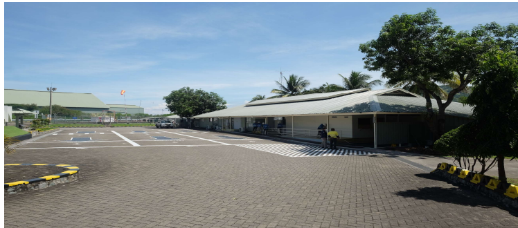
Gambar 8. Bangunan Terminal Penumpang Bandar Udara Khusus Perairan Benete Sumber : Peneliti, 2022
