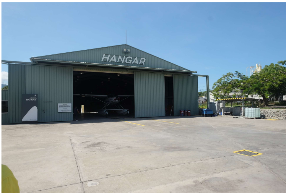
Gambar 9. Bangunan Hangar Bandar Udara Khusus Perairan Benete
