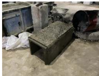
Gambar 4.5 Hasil Pembuatan Saluran U-Ditch
