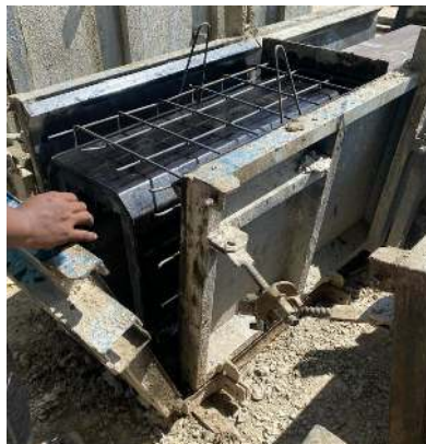
Gambar 4.4 Pemasangan Besi Tulangan
