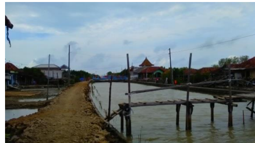
Keadaan permukiman penduduk lokal Dukuh Pandansari yang mengapit tambak.
