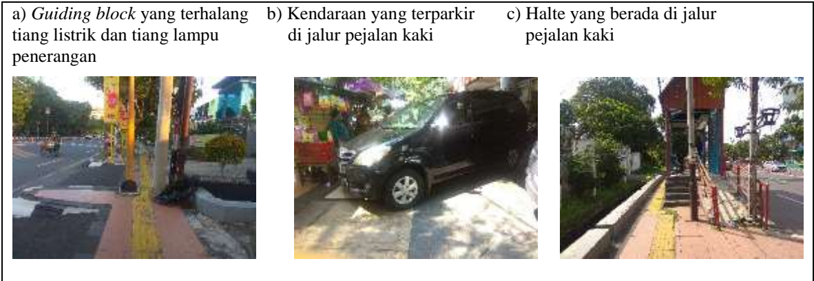
Gambar 2. Kondisi jalur pejalan kaki
