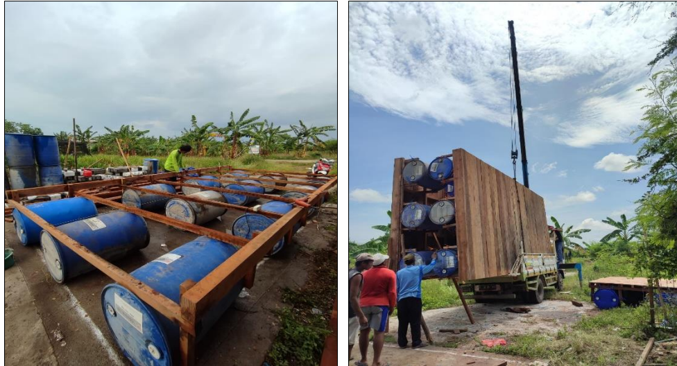
Gambar 4. Proses Perakitan dan Pengangkutan Plat Apung
