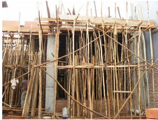
Gambar 1 Bekisting Konvensional
