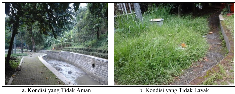
Gambar 3. Kondisi Jalur Pejalan Kaki
